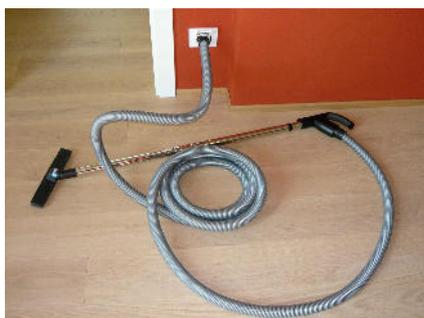
In ogni unità immobiliare sarà installato un impianto individuale di aspirazione polveri, composto da tubazioni integrate nella struttura edilizia e da bocchette di aspirazione, posizionate in punti strategici e da una centrale di aspirazione installata in apposito vano tecnico esterno.
